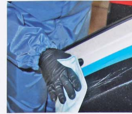
Die Reparatur ist unkompliziert. Zunächst wird die beschädigte Stelle entfettet und gereinigt.
