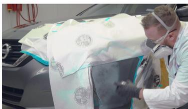
9. À une distance de 40 cm (16 po), sécher avec une lampe infrarouge à 800 watts pendant 20 minutes. Un pistolet à air peut être utilisé en alternance pour accélérer le séchage.
