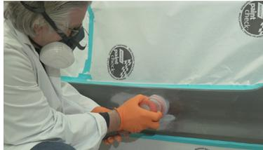
3. Poncer mécaniquement l'endroit endommagé avec le P220, puis le P400.
