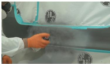
10. Laisser évaporer pendant 10 minutes. Un pistolet à air peut être utilisé pour accélérer le séchage.
