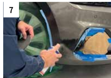
7 Reinigen mit Aqua-Silikonentferner
