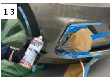
13 An den Randzonen Beispritzverdünnung applizieren, danach optional IR trocknen
