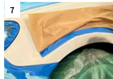
7 Schadstelle ablüften (Lufttrocknung) und Randzone schleifen mit P500
